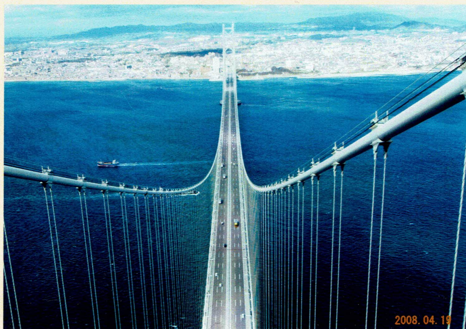
明石海峡大橋 タワー頂上から神戸方面を臨む。
